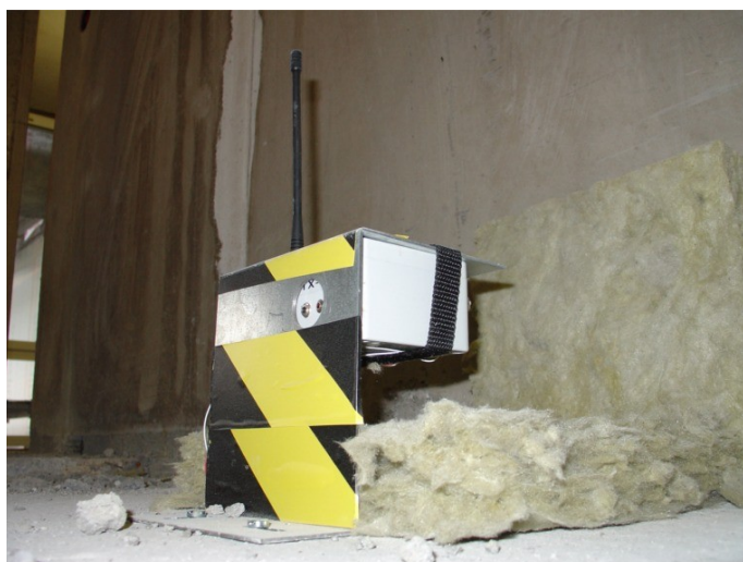
Figur 1. Bild på sändare i Betongdatorn systemet
